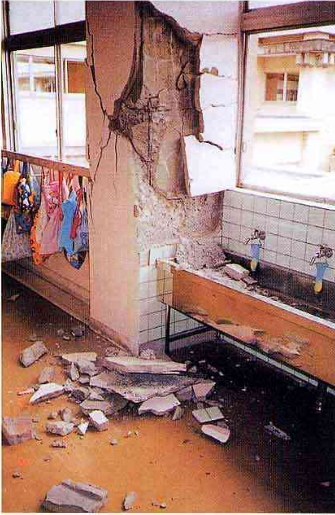
校舎の柱などに多数の亀裂が入り半壊状態となった会見小学校
