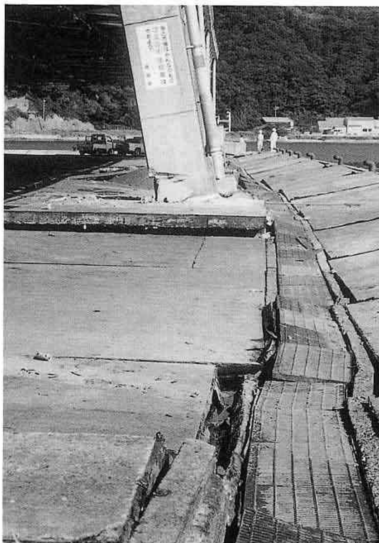
境漁港「かにかご岸壁」の被災状況
