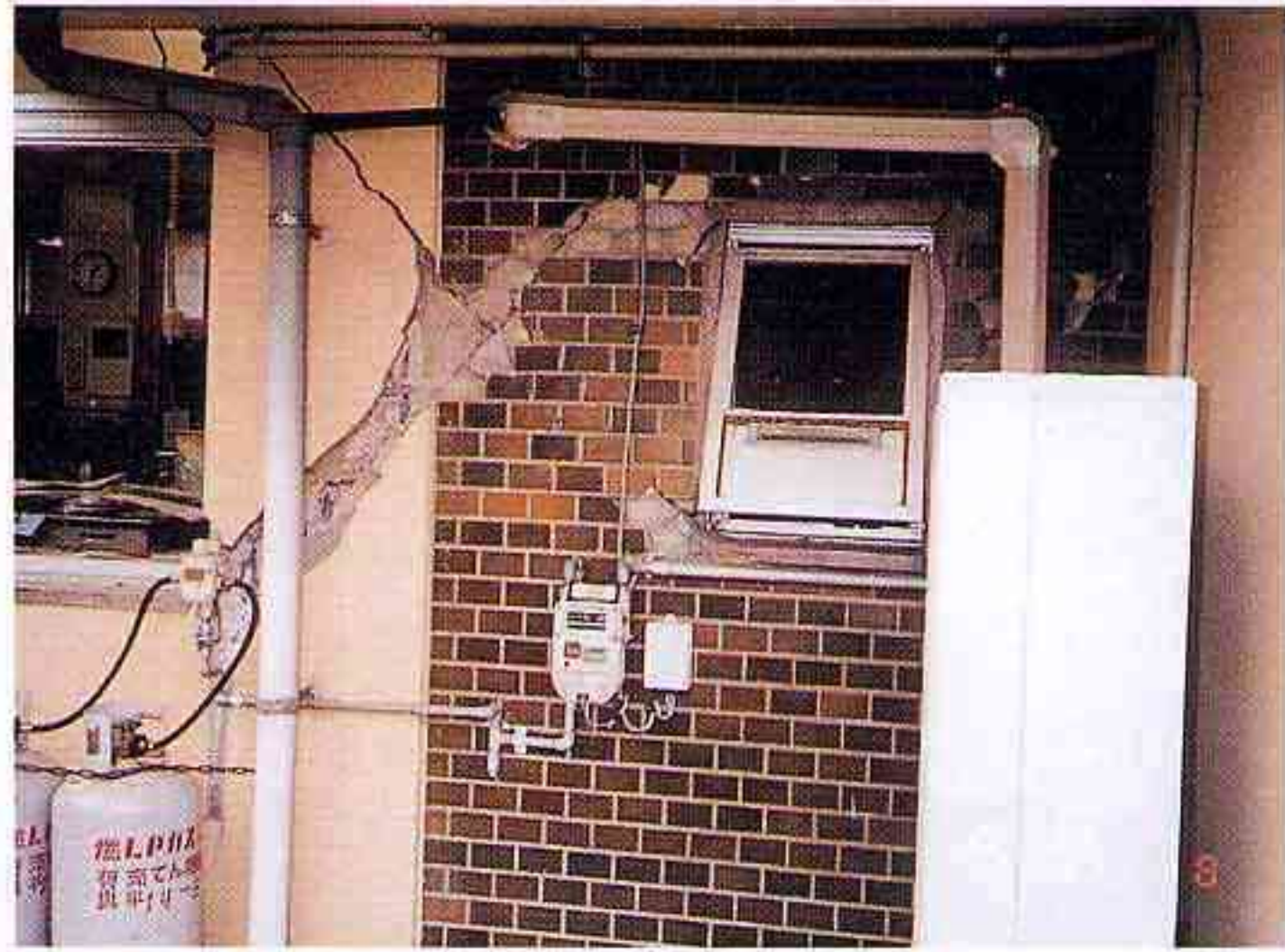
校舎の柱などに多数の亀裂が入り半壊状態となった会見小学校
