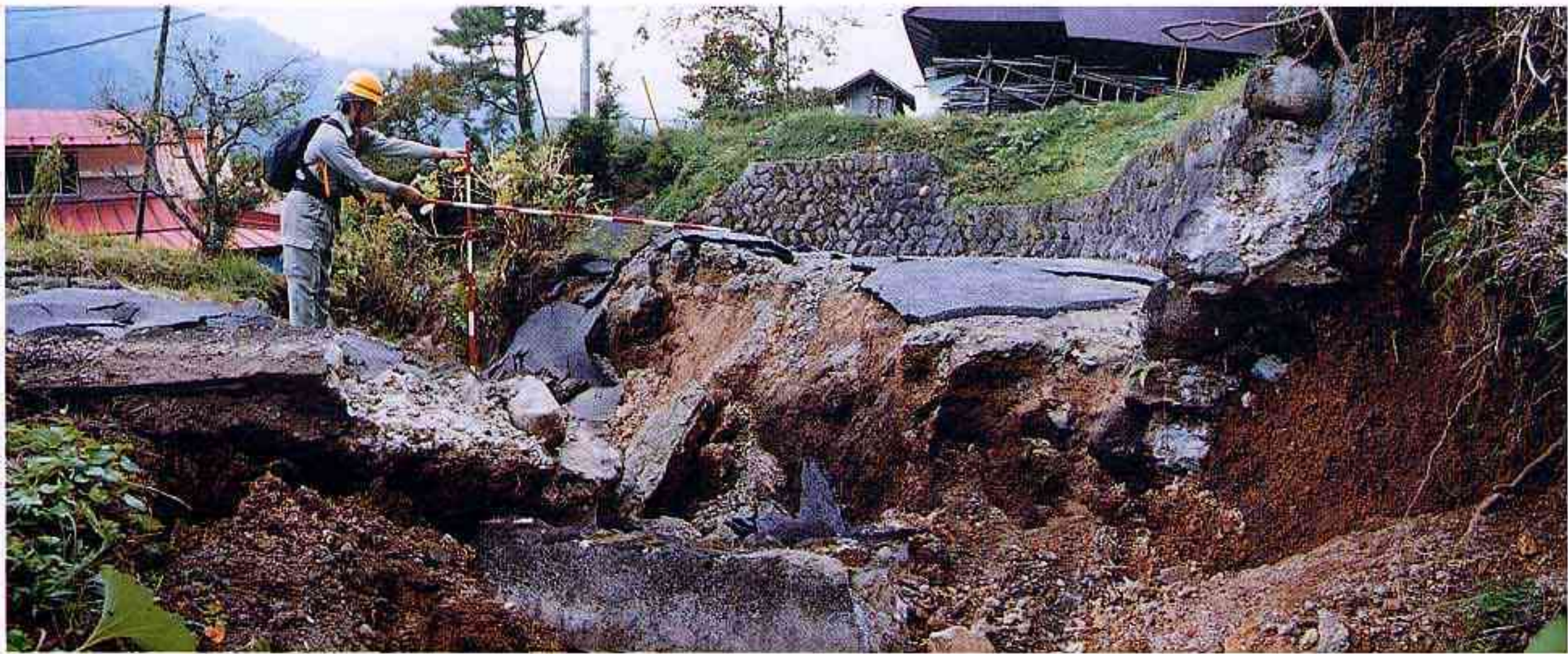
日野町下黒坂地区 地滑りによる崩落
