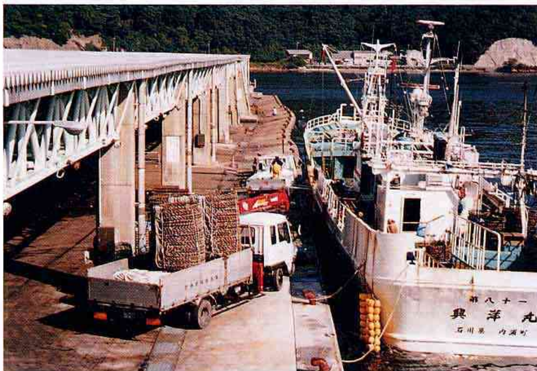
境漁港 約120mにわたり湾曲したかにかご岸壁
