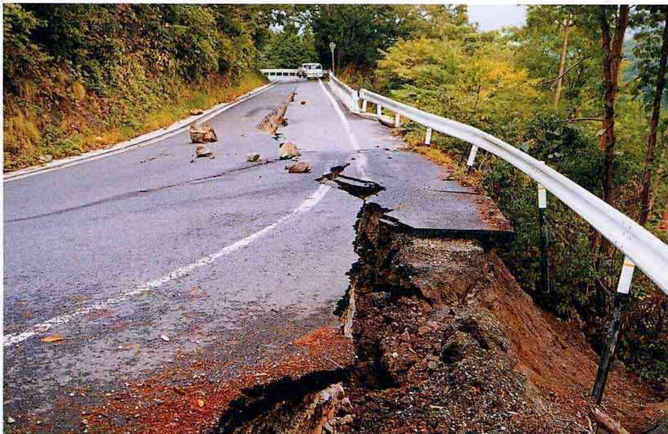
主要地方道岸本江府線における路肩崩壊と道路亀裂（江府町）
