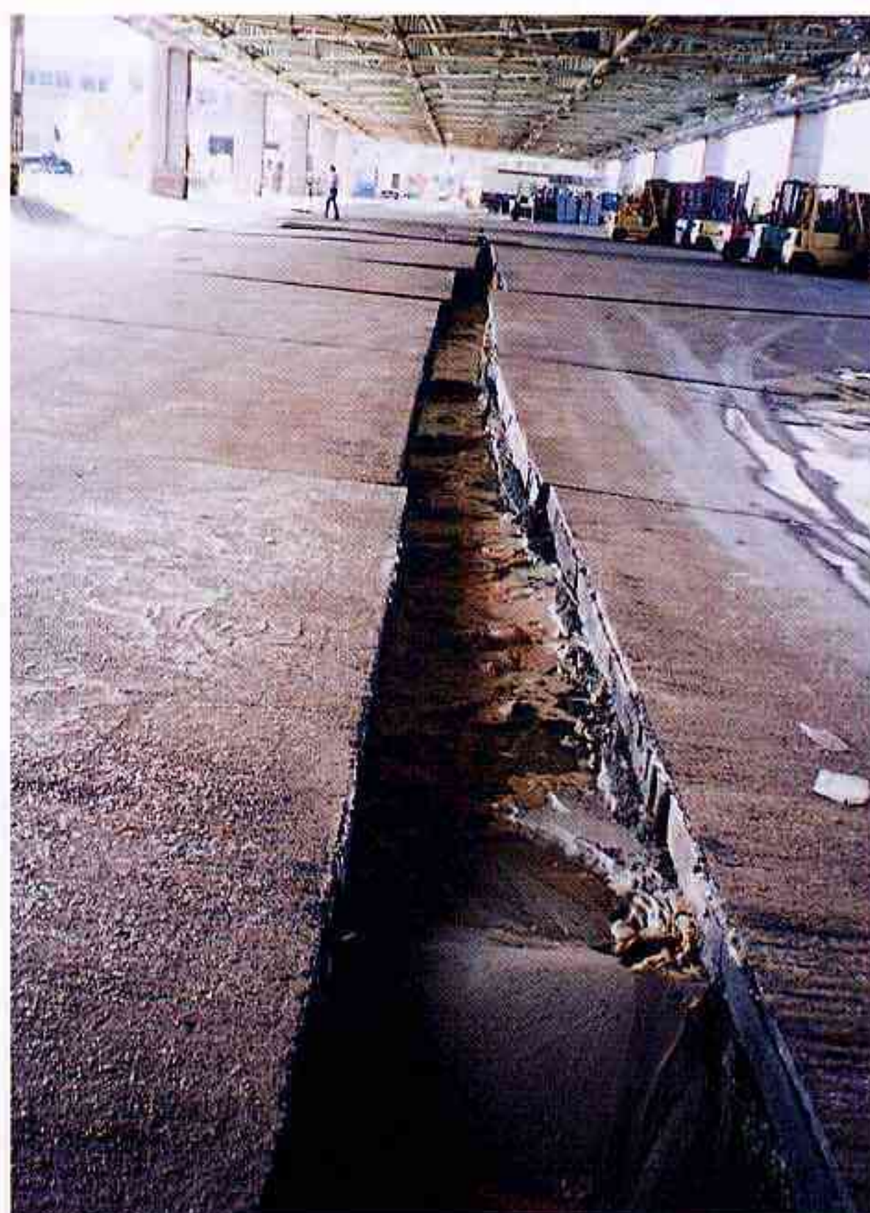
市場内の亀裂（長さ100m、幅0.4m）
