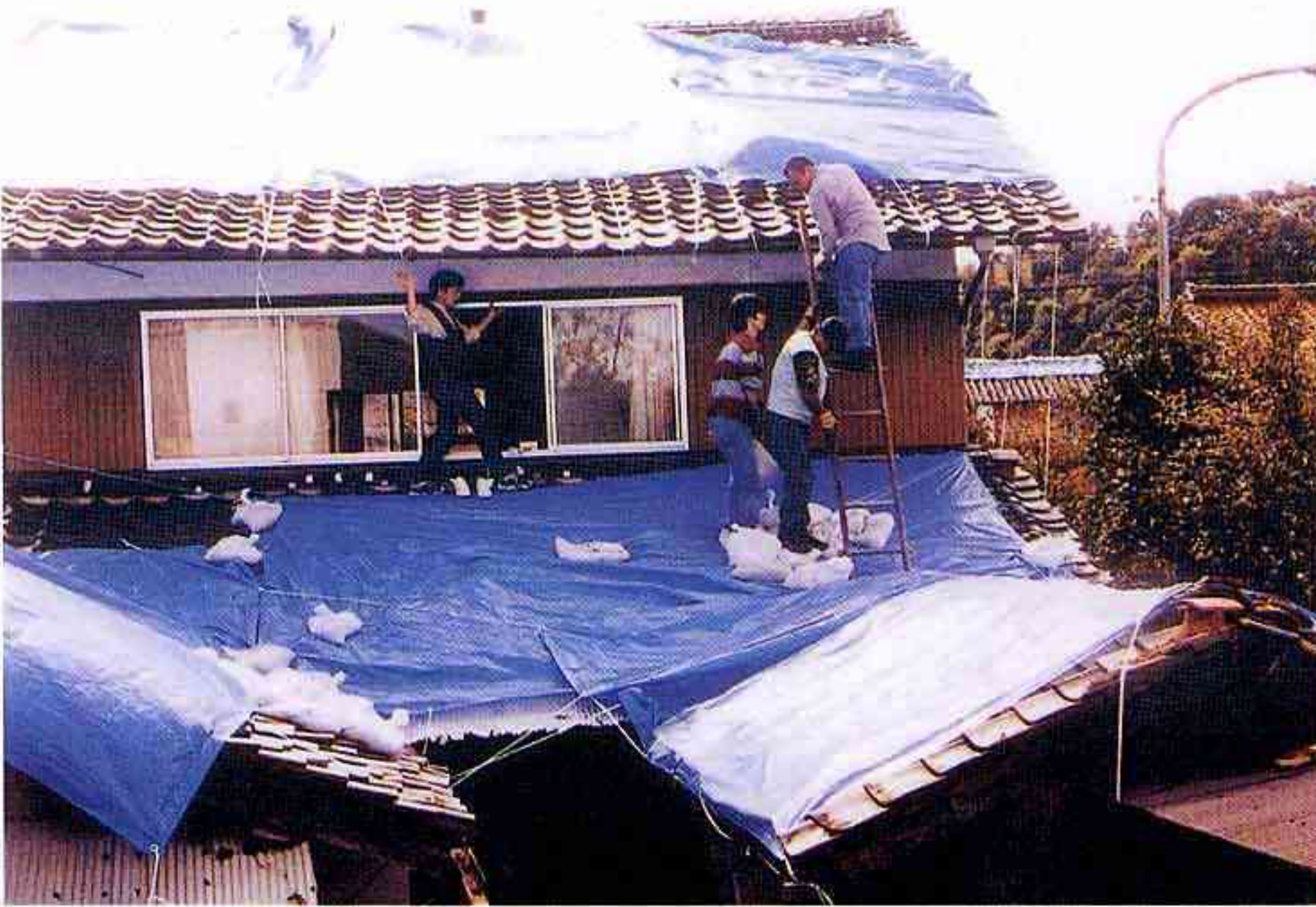
シート張りをするボランティア（西伯町）
